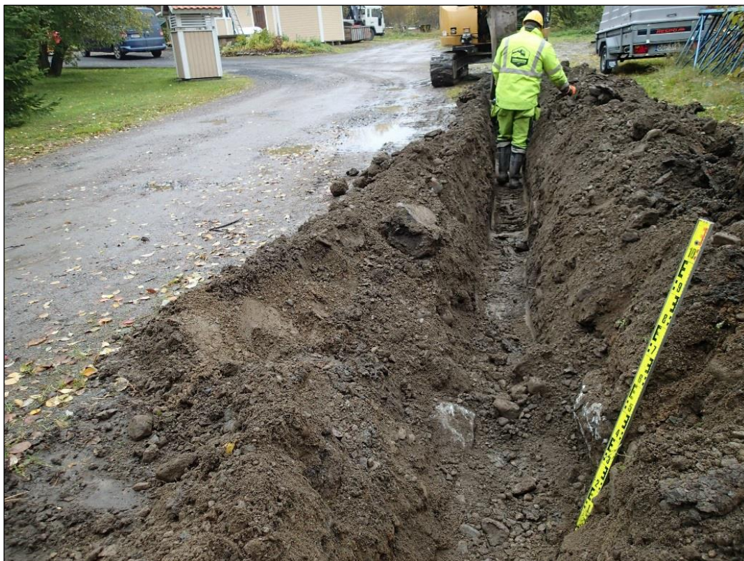
Havainto 2. Kaakkoon. Seinälinjalta vaikuttavat kivet näkyvät heti latan takana. Kahden kiven välistä on kaivettu pois yksi iso kivi. Kivet ovat kiinni pohjasavessa. Niiden yhteydestä ei löydetty muuta ehjää rakennetta.
