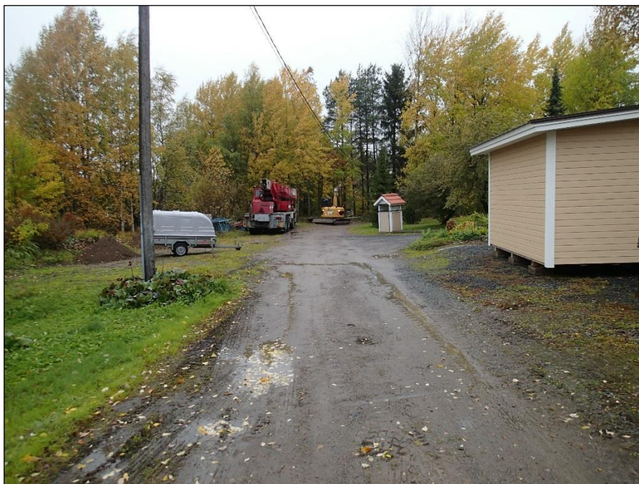
Luoteeseen. Kaivualan loppupää ennen kaivua. Kaivu päättyi etualan sähköpylväälle.
