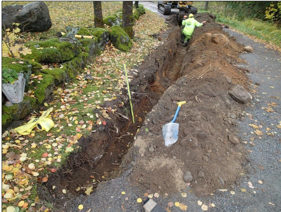
Lounaaseen. Ojan pohjoinen alkupää auki kaivettuna. Pintakerrokset vaikuttavat tien parantelussa syntyneiltä. Pohjamaa on suurikivistä ja soraista hiekkaa, jossa ei ole huuhtoutumiskerrosta. Latan kohdalla havaittiin tiilimurskaa (havainto 1).
