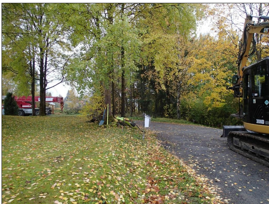
Lounaaseen. Kaivualue ennen aloittamista. Ojan kaivu aloitettiin postilaatikkojen takaa.
